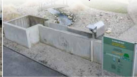
La clarification et le rejet à l'Isère. Après une ultime décantation, qui permet de séparer l'eau épurée et les boues ; l'eau, débarrassée des matières organiques, est rejetée dans le milieu naturel. Bien sûr, elle n'est pas potable mais sa qualité permet un rejet sans risque pour l'écosystème au milieu naturel.
