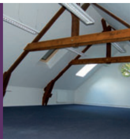
La rénovation de l'ancienne garderie en pôle artistique, menée de main de maître
