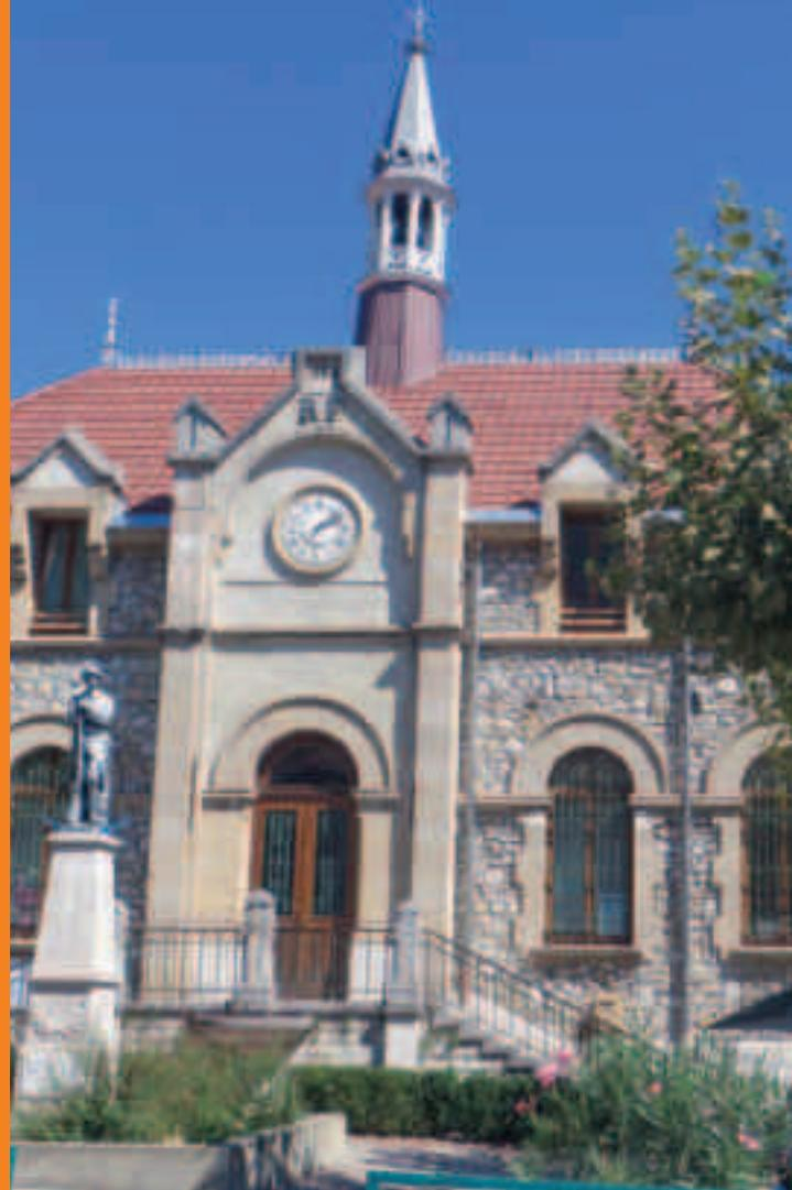
**Réfection de la toiture** du bâtiment central de l'école élémentaire cet été. Nouvelle isolation, remplacement des bardeaux par des tuiles comme pour les bâtiments de l'aile nord et de l'aile sud.
