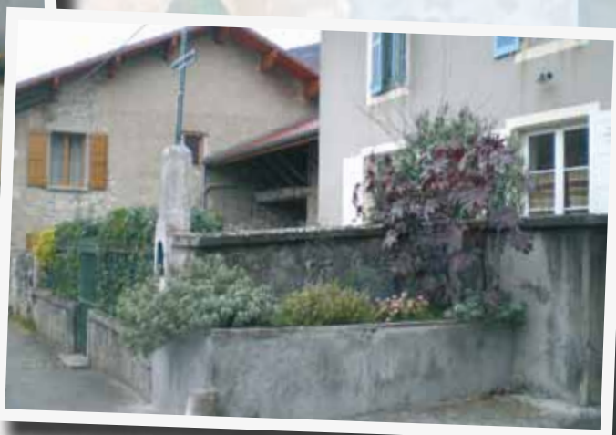
... et après les travaux
