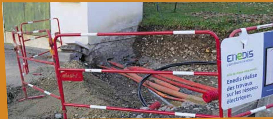
**Enedis réalise les travaux d'enfouissement de la ligne électrique haute tension qui traverse le Touvet**, pour fiabiliser le réseau et éviter les problèmes de coupure de courant lors des intempéries. Les travaux ont débuté en septembre et se poursuivent dans la zone artisanale du Bresson. Rue du Gouverneur, Chemin des Grapillons, rue de la Perrière, intersection Grande rue/route du Bresson, route du Bresson, rue de Préponton, à venir rue des Corvées jusqu'à Goncelin.
