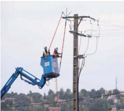
Durant 3 jours, du 15 au 17 juillet, une équipe de 4 agents ERDF (TST) spécialisés et habilités pour travailler sous tension sur le réseau 20.000 volts a été mobilisée afin de poser des dispositifs de protection sur sept pylônes dans le secteur de **Monestier du Percy**. Outre la pose des tiges et des perchoirs, ils posent de multiples accessoires isolants sur cette partie du réseau électrique.
