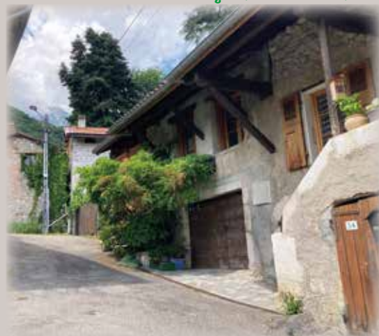
Maison de vigneron au Vivier
