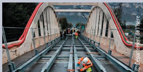
Les travaux de pose du platelage, qui ont débuté le 15 novembre 2022, sont la solution provisoire la plus rapide et la plus sûre pour permettre de désengorger les voies de déviation aux heures de pointe
